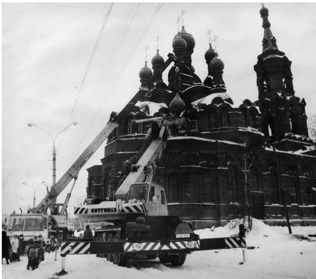
Монтаж куполов Свято-Троицкой церкви
