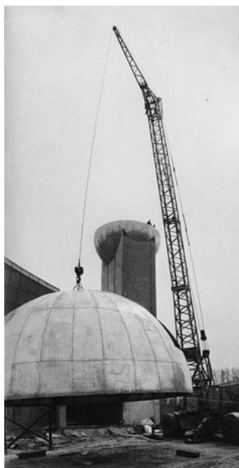
Монтаж «шара» обсерватории Дворца пионеров и школьников
