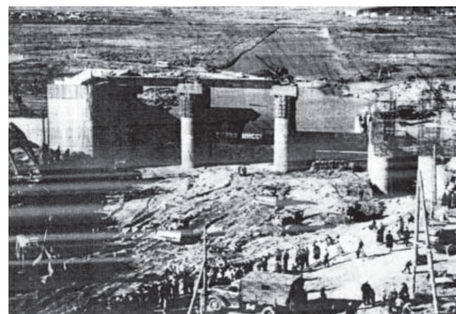
Строительство Шершневского гидроузла
