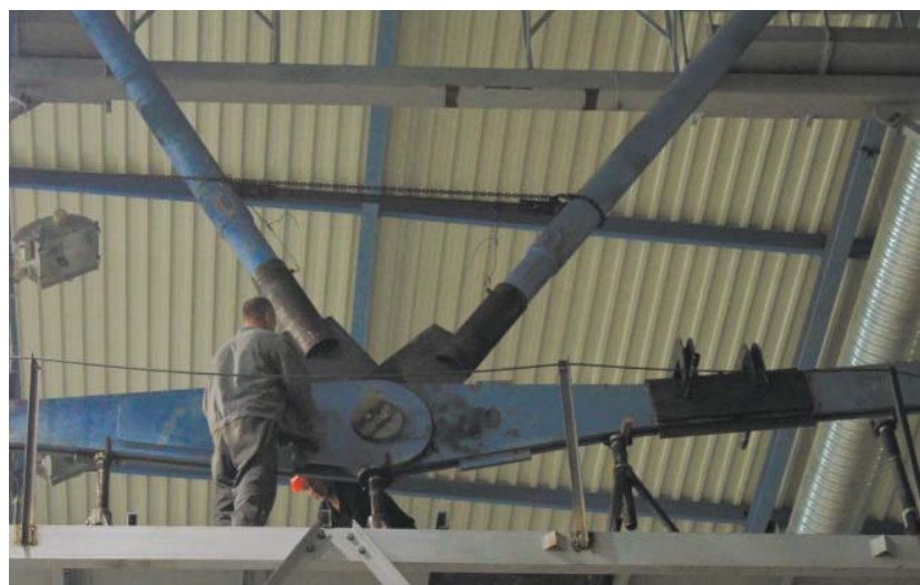
Ледовый дворец «Уральская молния». Восстановление поврежденных конструкций. Август 2013 г.
