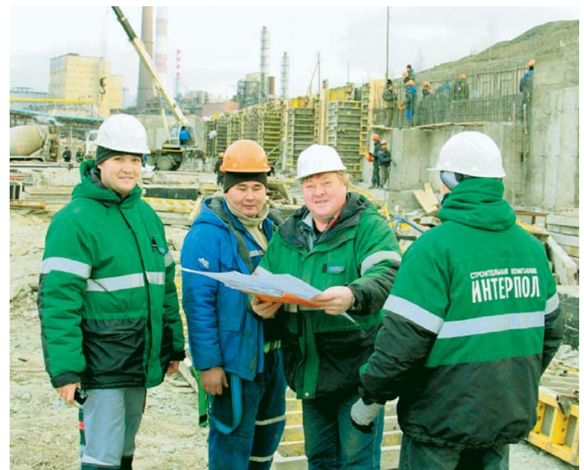
Газопоршневая станция медеплавильного завода, где сегодня работы только разворачиваются, станет для строителей одним из основных карабашских объектов в 2014 году
